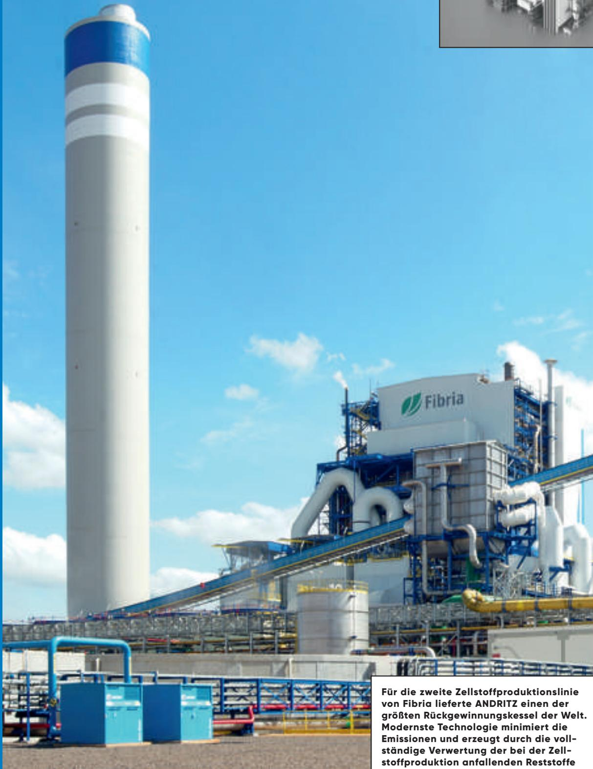
Für die zweite Zellstoffproduktionslinie von Fibria lieferte ANDRITZ einen der größten Rückgewinnungskessel der Welt. Modernste Technologie minimiert die Emissionen und erzeugt durch die vollständige Verwertung der bei der Zellstoffproduktion anfallenden Reststoffe „grünen“ Strom. Damit kann die gesamte Anlage energieautark betrieben und sogar noch überschüssiger Strom an das öffentliche Netz abgegeben werden.
